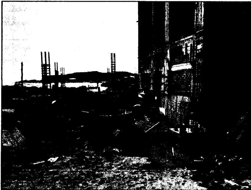
Armadura de refuerzo de las columnas del PTAR
