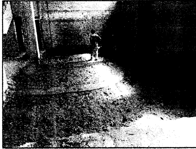
Colocación y compactación de afirmado en los pisos de los equipos de frio – Edificio de Frio
