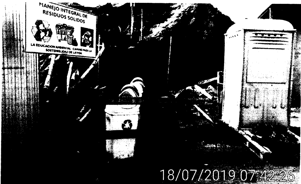
Imagen N°6: A la vista de la imagen se aprecia que el área de los residuos sólidos está señalizada y rotulada de acuerdo a la G050 de construcción Civil.
