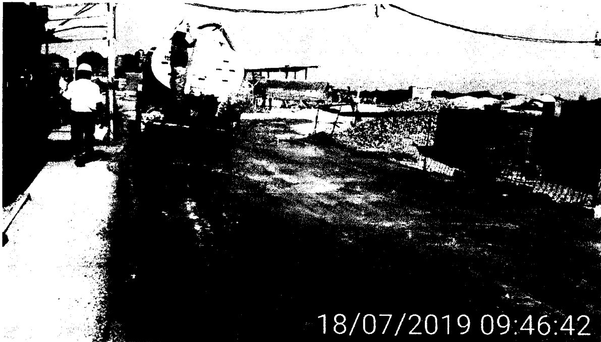
Imagen N°7: En la imagen se aprecia que en las áreas ingreso de los vehículos a obra se hace mitigación de la polvareda de acuerdo a la G050 de construcción Civil y cuida dar el medio ambiente.
