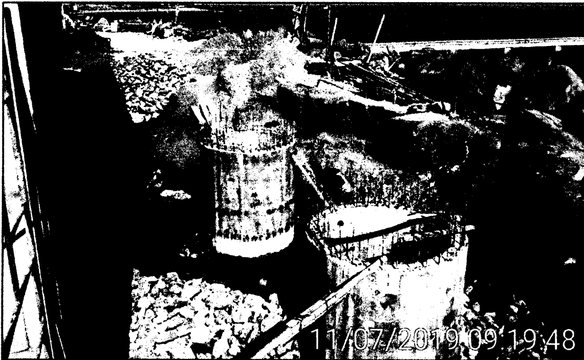
Imagen N°8 La imagen muestra que los trabajadores han desencofrado donde se instalaran las cámaras de bombeo y eculización
