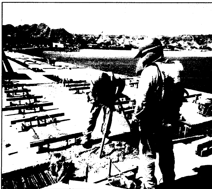
Vaceados in situ en los núcleos del cabezo del muelle
