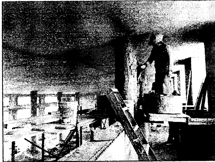
Tarrajeo en columnas circulares en Tareas Previas
