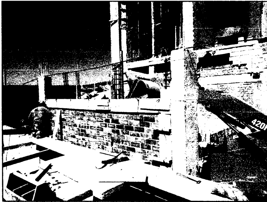
Colocación de ladrillo tipo IV saga en muros del PTAR
